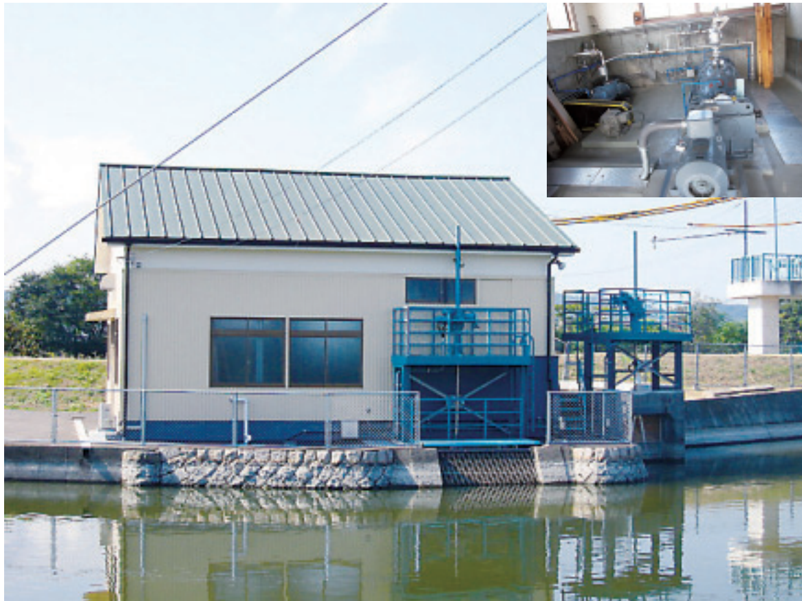
「五十番機場」の建屋とその内部（4頁に詳細解説）
