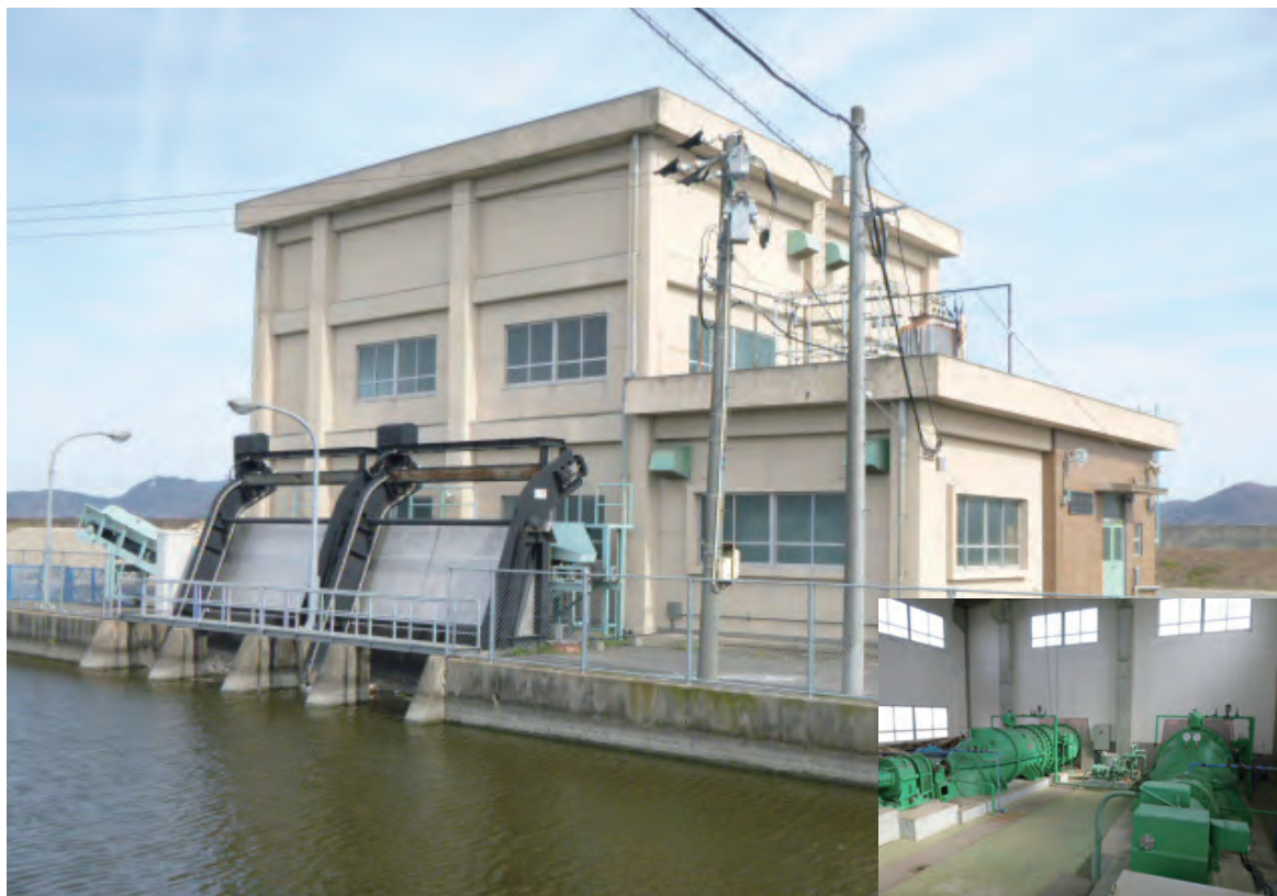
「妹尾川機場」の建屋とその内部（10頁に詳細解説）
