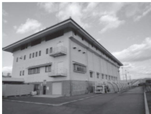
巨椋池排水機場の建屋
