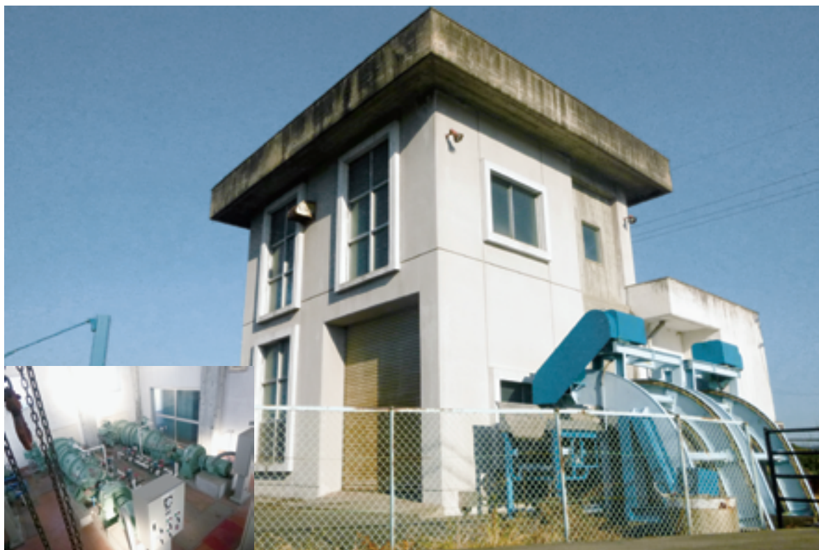
「大曲機場」の建屋とその内部（10頁に詳細解説）
