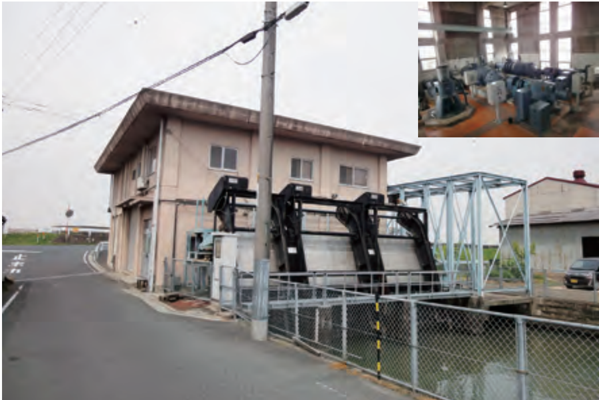
「浦安西機場」の建屋とその内部（12頁に詳細解説）
