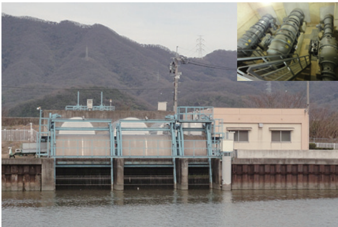
「東南七区機場」の建屋とその内部（11頁に詳細解説）
