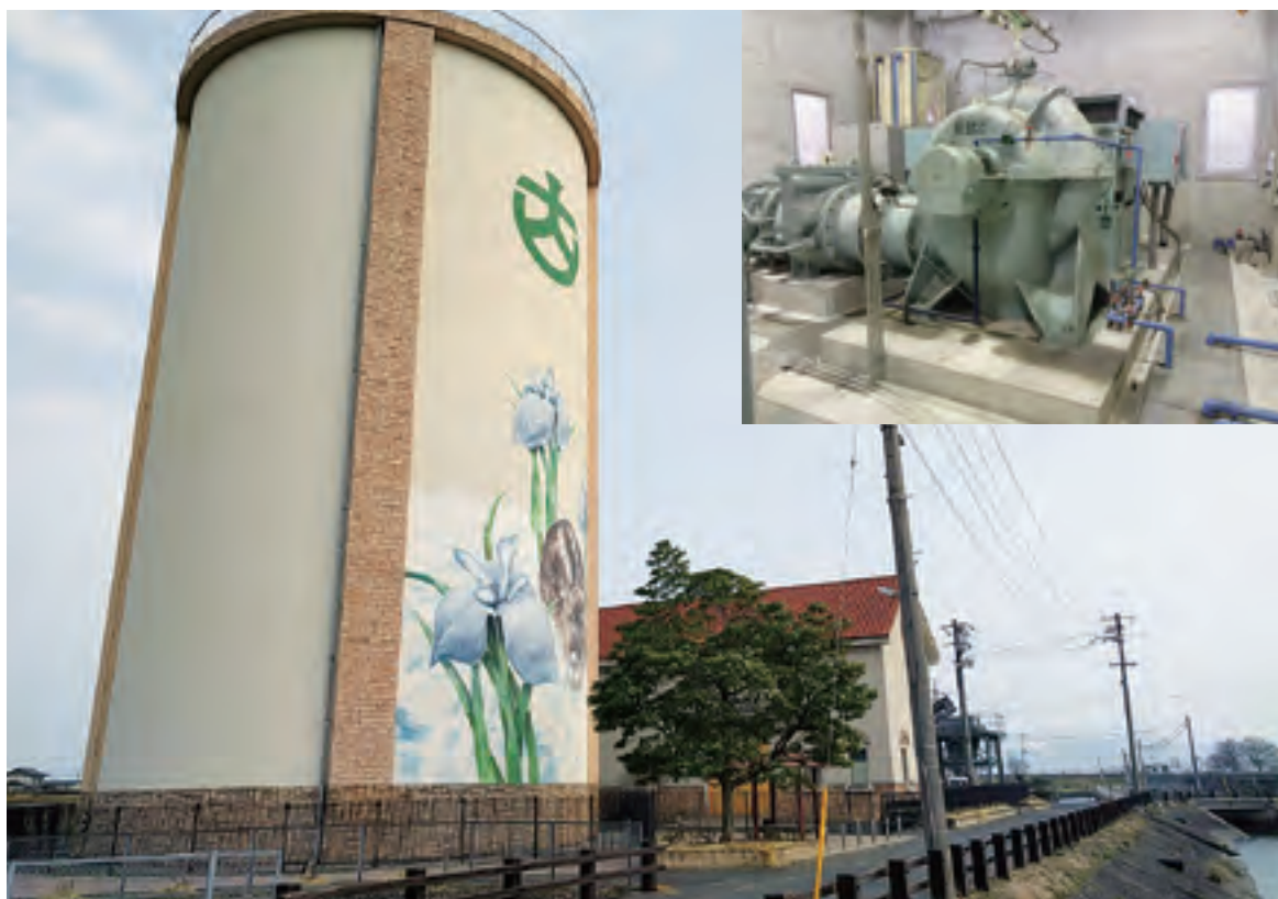
「大曲用水機場」の建屋とその内部（8頁に詳細解説）
