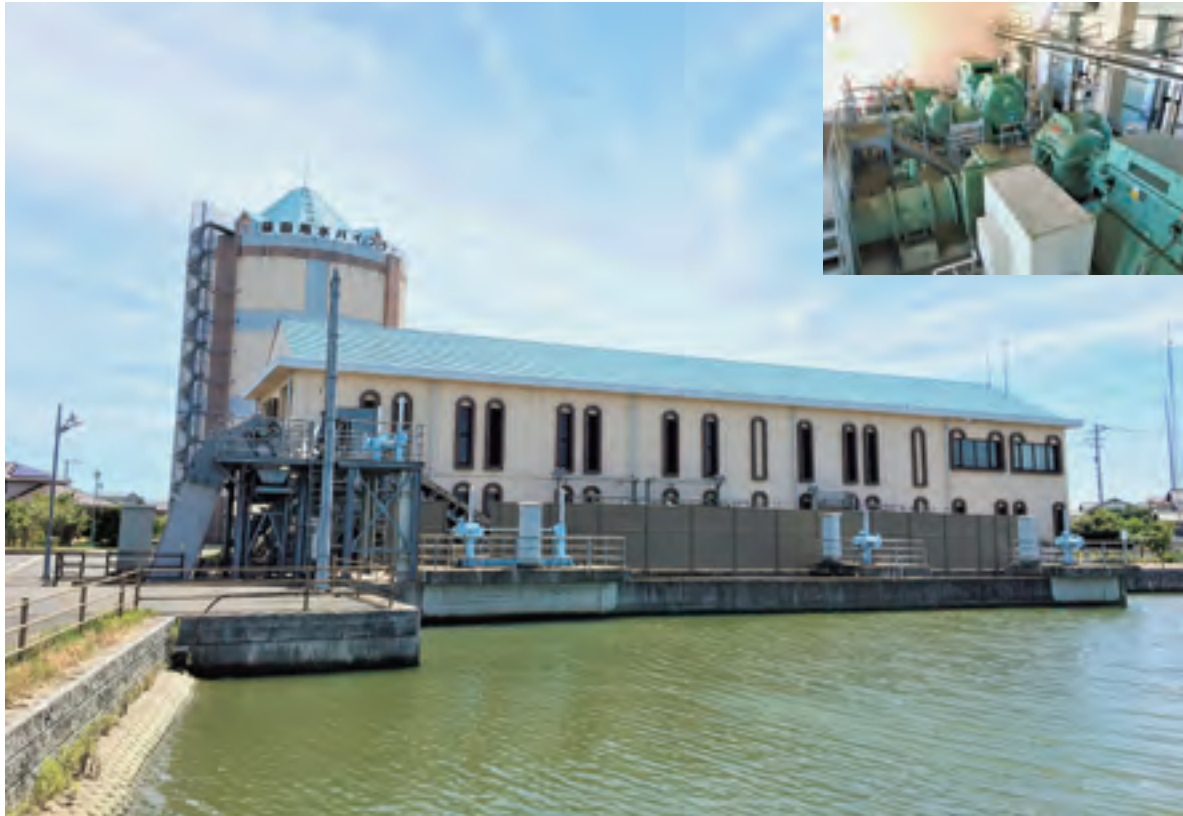
「藤田用排水機場」の建屋とその内部（8頁に詳細解説）
