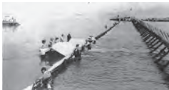
図2 汐止口基礎用沈床
