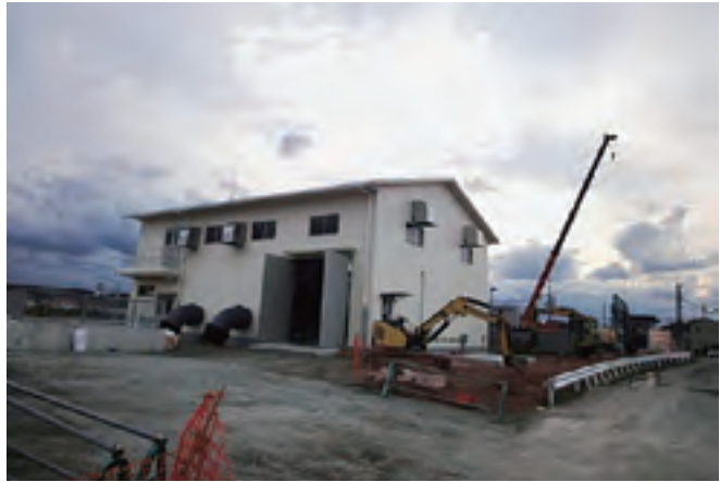
建設中の米田排水機場
