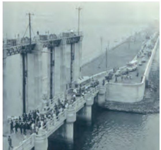
図2 完成した締切堤防
