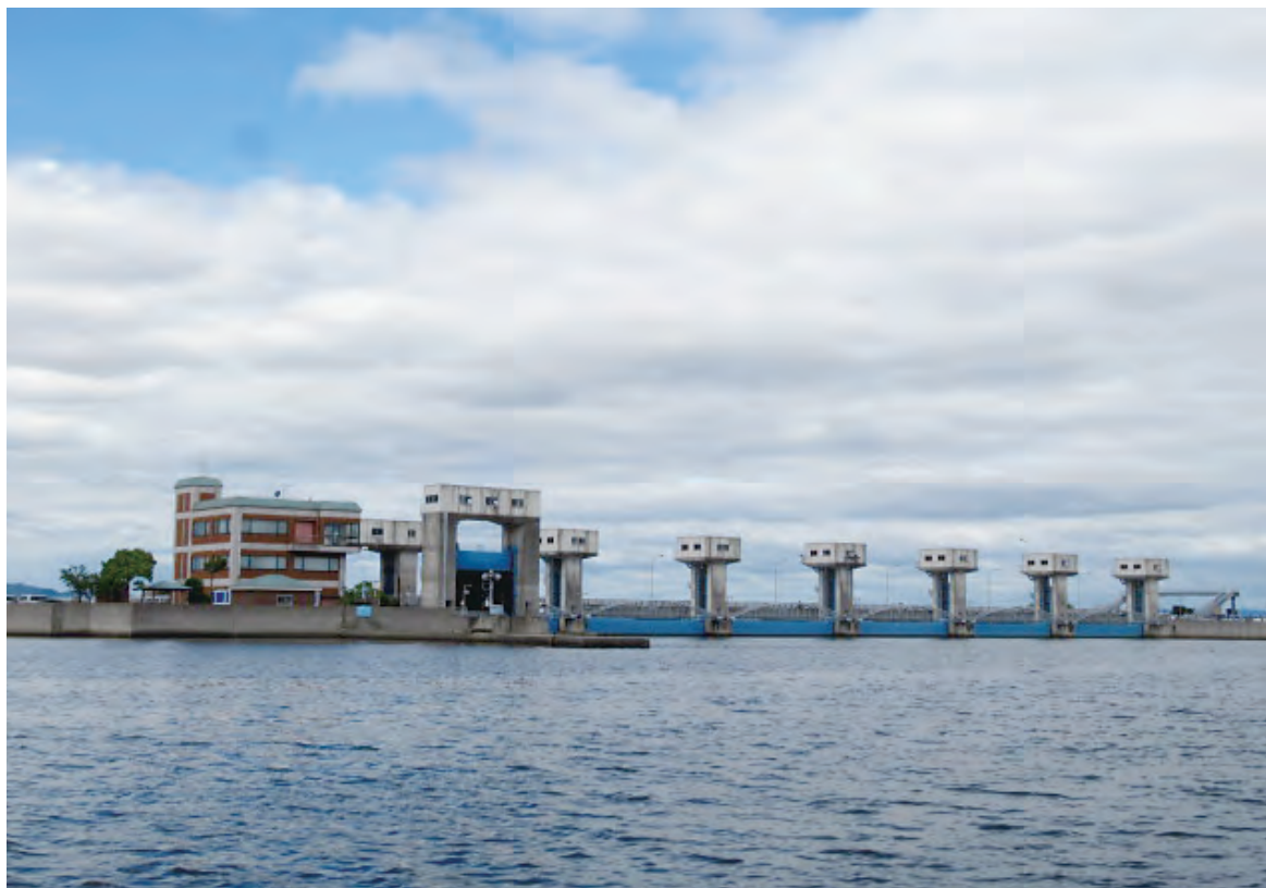
締切堤防と中央管理事務所
