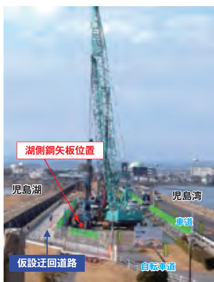
【工事中の全景写真】
