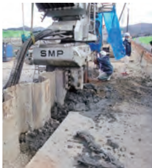
【鋼矢板設置状況写真（硬質地盤クリア工法）】
