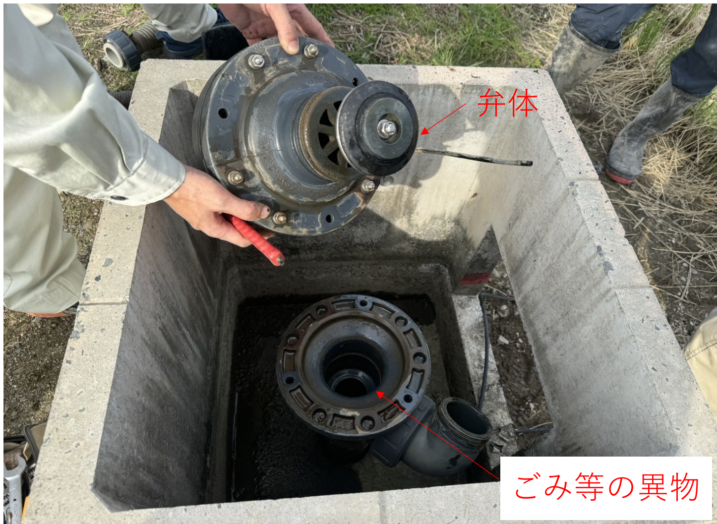
給水栓分解状況
